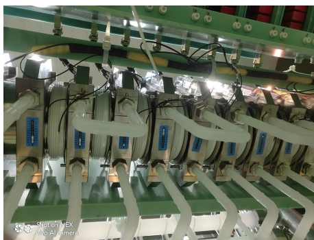
图15 传感器现场安装
